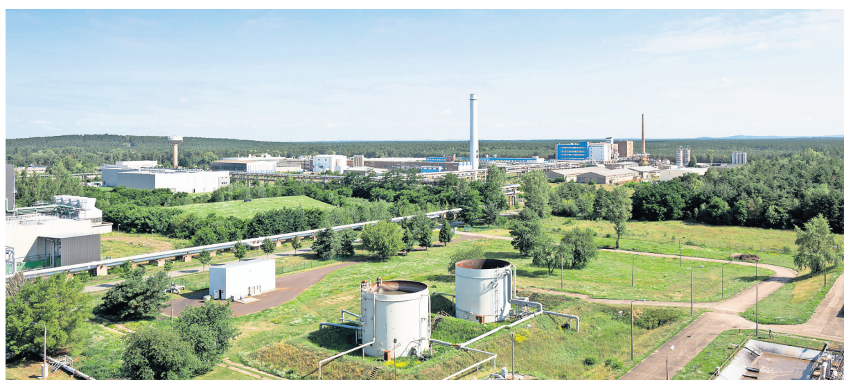
Im Industriepark Premnitz sollen die Straßenlampen mit einem intelligenten Dimm-System versehen werden. Bezahlt wird es mit Geld aus dem Sondervermögen.
